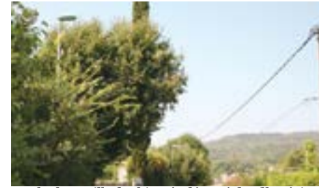
Le ch. des Caillades bientôt dégagé des fils aériens disgracieux
