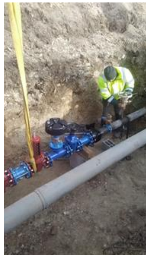
Quartier village : mise en place d'une chambre de régulation.
