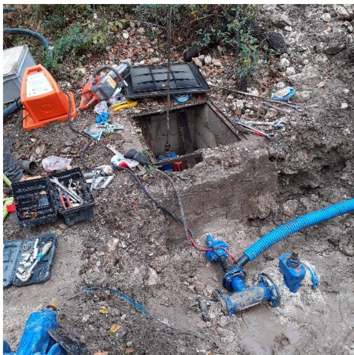
Quartier St Pons : mise en place d'un bypass afin de réguler au mieux le quartier du Thoronet.
