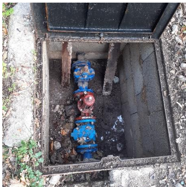
Quartier St Pons : mise en place d'un bypass afin de réguler au mieux le quartier du Thoronet.
