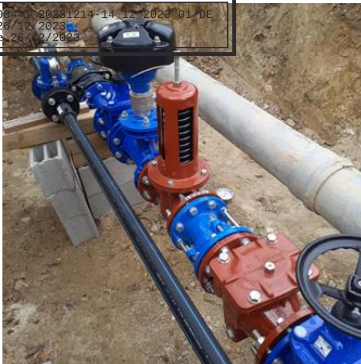
Quartier village : mise en place d'une chambre de régulation.
