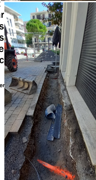
Reprise des branchements existants
