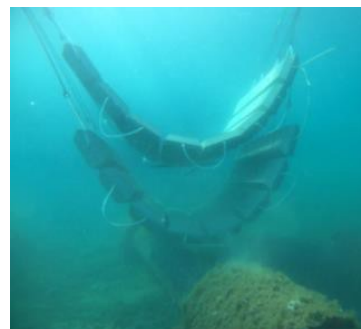
Travaux de réfection des matelas de stabilisation de l'émissaire de la STEP de Vallauris
