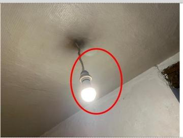
**Description:** L'ENVELOPPE d'au moins un matériel est manquante ou détériorée. Observation(s) Prises cassées, couvercle manquant, protection mal fixée
