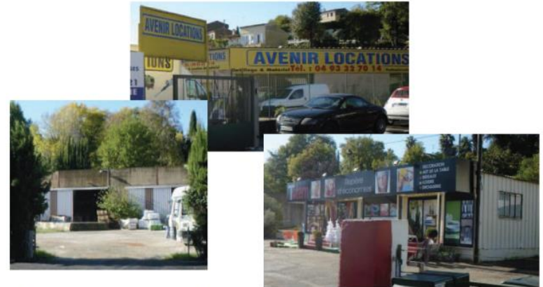
Des constructions hétéroclites de mauvaise qualité
